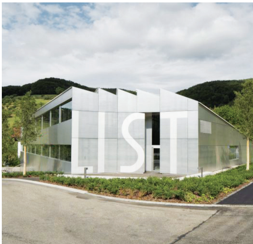
LIST Hauptsitz und Test Center in Arisdorf, nahe Basel, Schweiz
